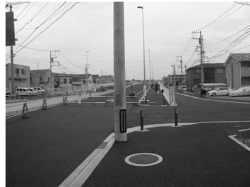
新吉田高田地区の歩道供用状況
