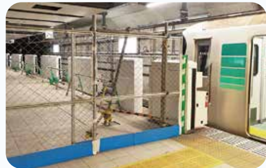
工事中の日吉駅ホーム
