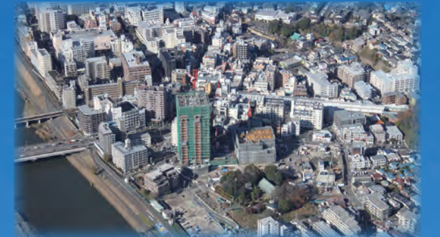
新綱島駅周辺の整備状況(消防局航空隊撮影)
