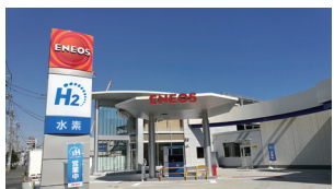
水素ステーション
