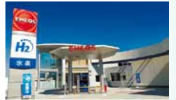
横浜綱島水素ステーション(綱島東4-3-9)
