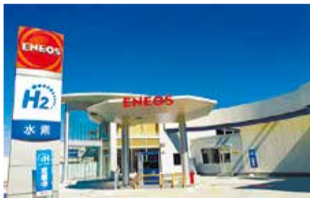
横浜綱島水素ステーション
