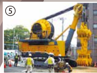
鋼製地中連続壁を造るのに使われた、日本に4台しかない特殊な重機(CSM機)
