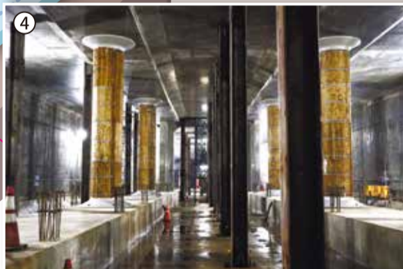
地下4階に新横浜駅(仮称)のホームができるところ
