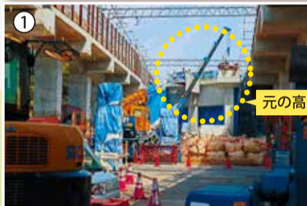
東急線の線路を外側に切り替えた後、元の高架橋を撤去している様子
