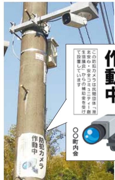
防犯カメラ設置看板
