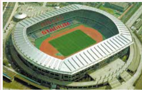
横浜国際総合競技場(日産スタジアム)
