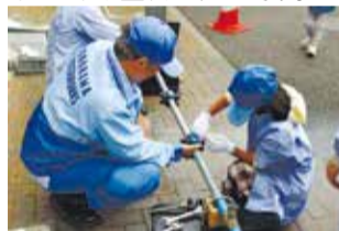
漏水修理体験
