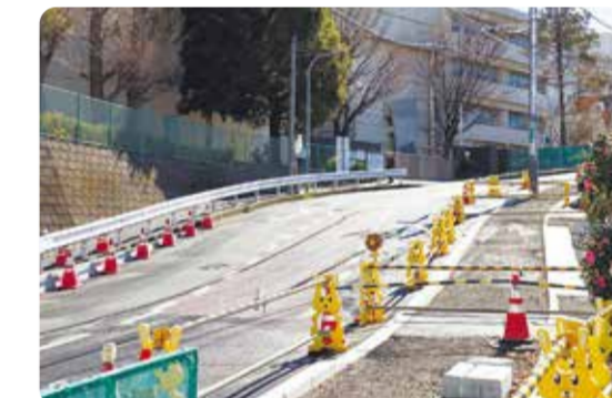
道路改良工事の状況
