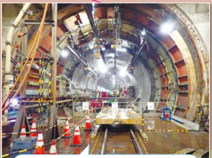
新綱島駅から発進したシールドマシンは新横浜駅に到達し、マシンが解体されてトンネルが繋がった
