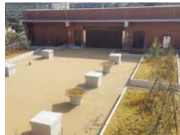
リニューアル工事中の屋上庭園(3月10日時点)
