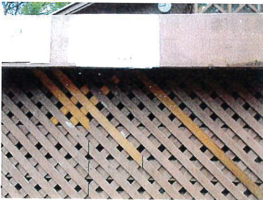
【舞台(ステージ)土台部分の小破修繕】
