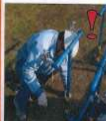
5-⑥ 蛇口を組み立て、黄色 のホースにつなげます。
