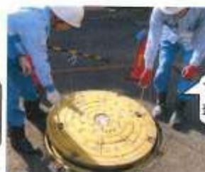
マンホールの 回りに安全錐 を設置します。
