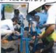
5-⑥ 蛇口を組み立て、黄色 のホースにつなげます。
