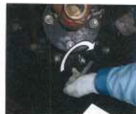
5-② 給水栓の下に設置されている補 修弁を開けます。 (レバーを右側へ45度倒し、O(OPEN) の表示に合わせる。)
