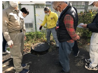
下水道管の確認
