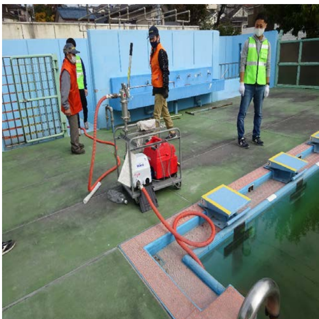
下水道直結トイレに使用するプールの水を汲む ポンプの設置
