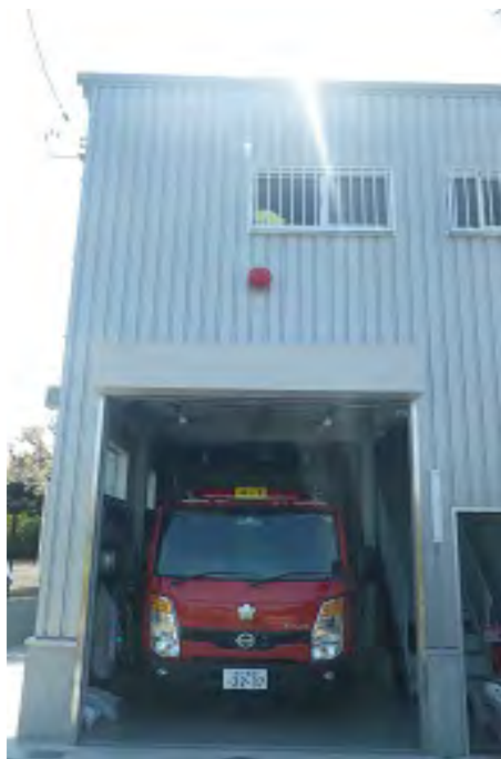
シャッター開放状態
