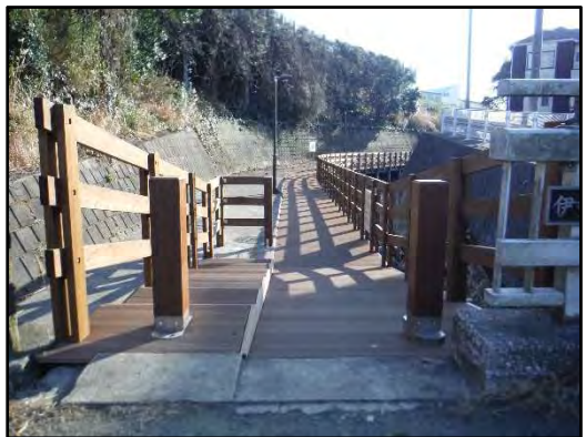
馬洗川せせらぎ緑道再整備
