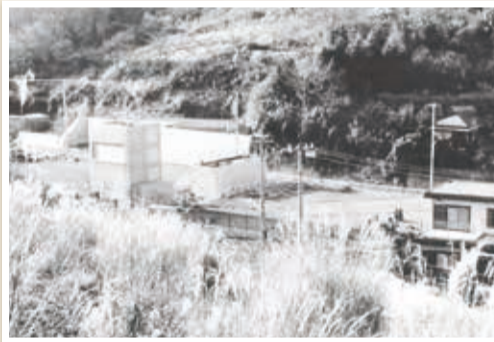
工事中の下永谷駅
