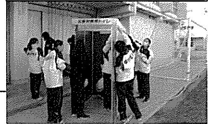
中学生による仮設簡易トイレの組立
