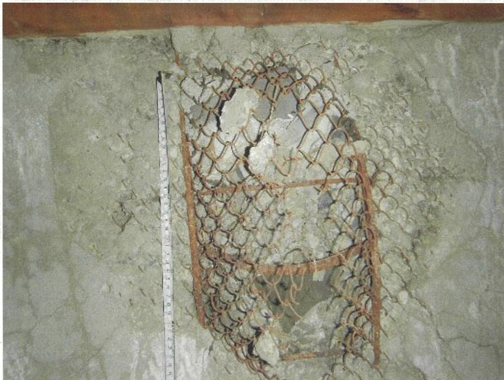
写真 28 金網コンクリート造屋根スラブの金網
