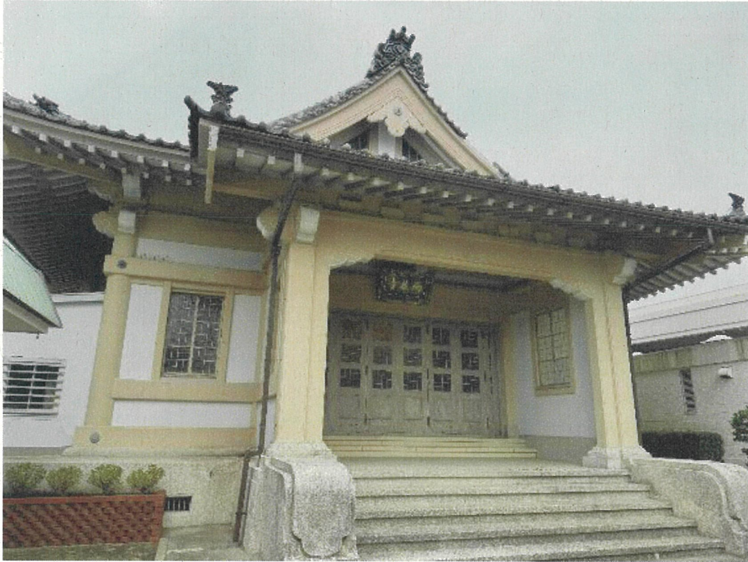
写真3 西教寺本堂正側面全景
