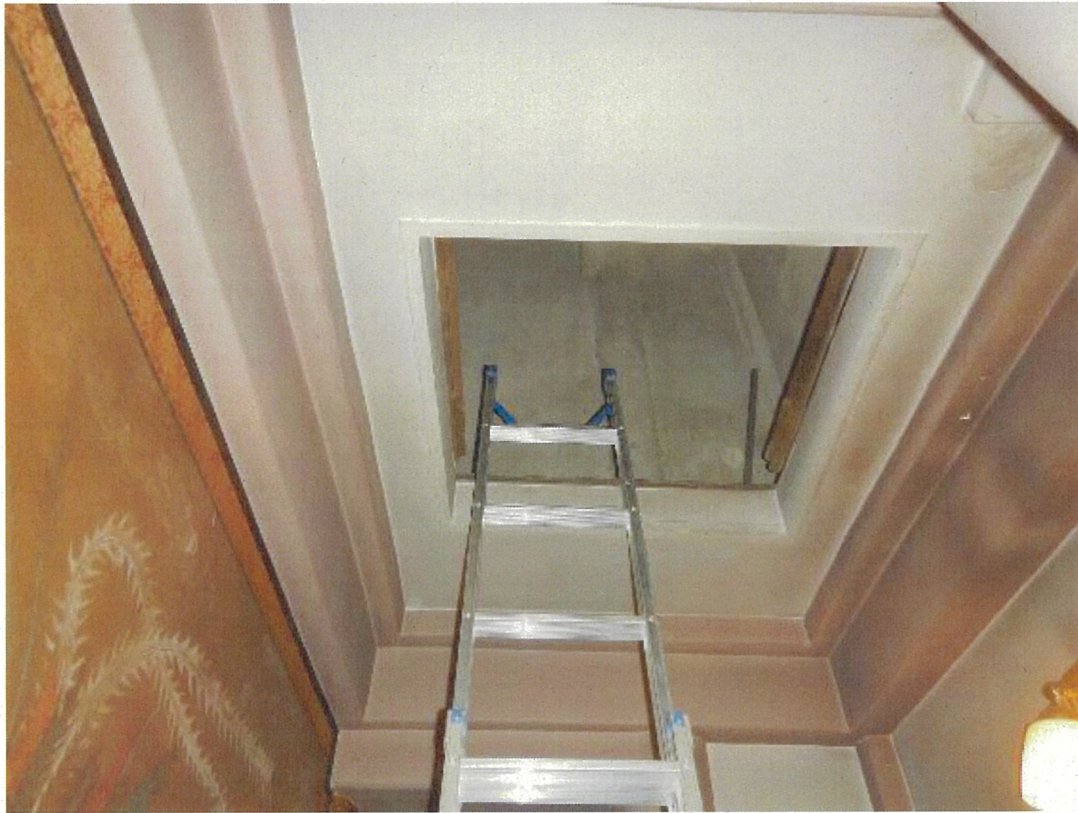
写真 25 西教寺本堂 仏後壁背面（後門）天井に設けた天井スラブ上への昇降口 鉄扉を備える。
