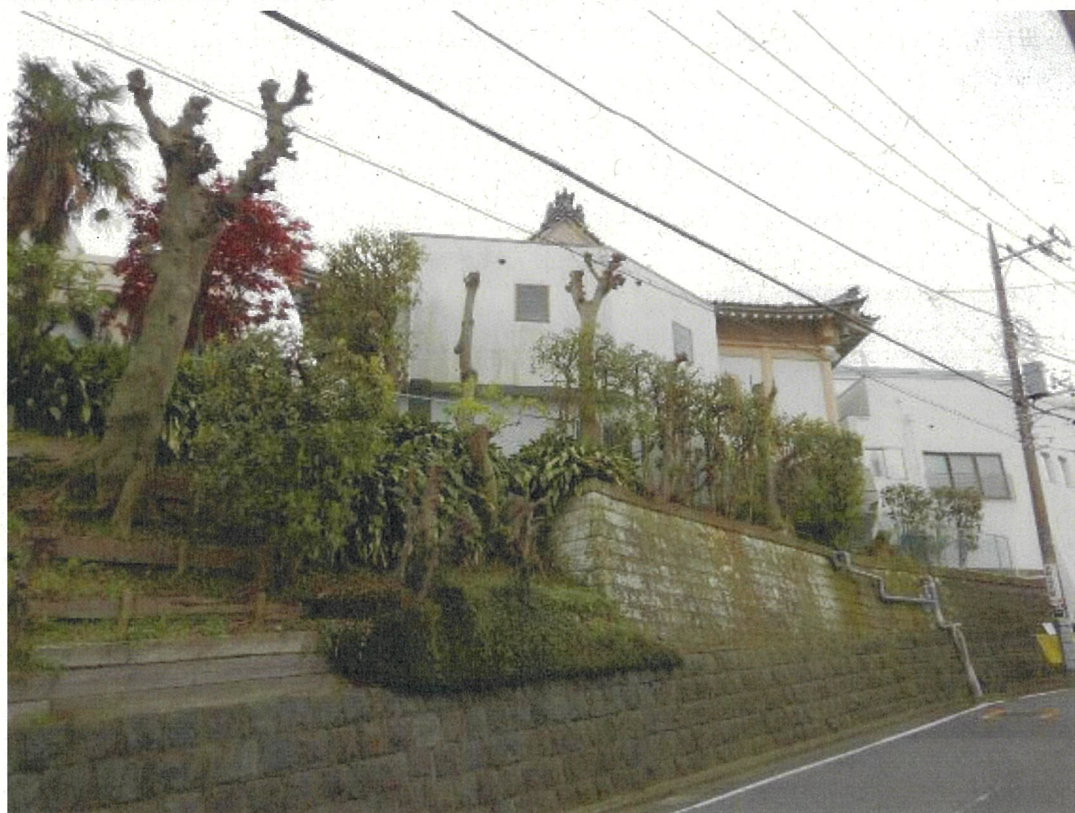
写真6 西教寺本堂 北面から見上げ（2020年4月撮影のため撤去した物置が写る） 下段の間知石積擁壁は、本堂竣工時から存在していたことが寺蔵古写真4でわかる。
