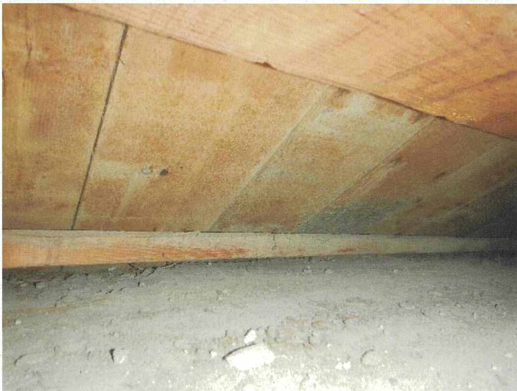
写真 30 屋根スラブ下辺
