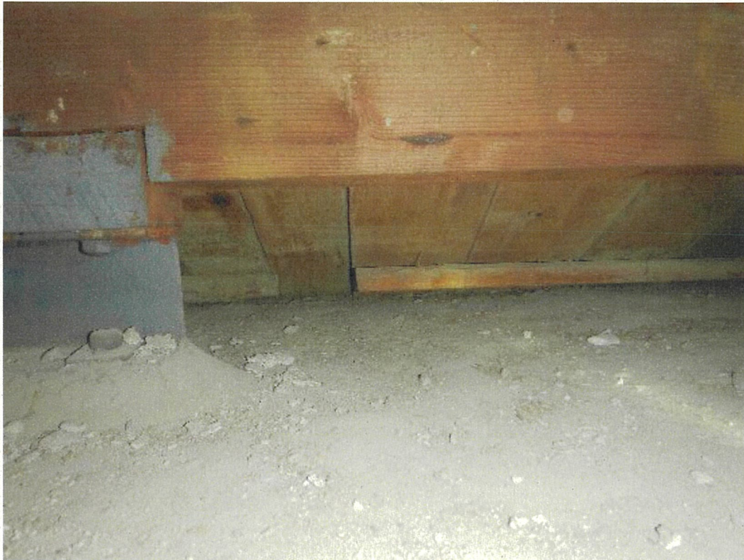
写真 29 屋根スラブ下辺
