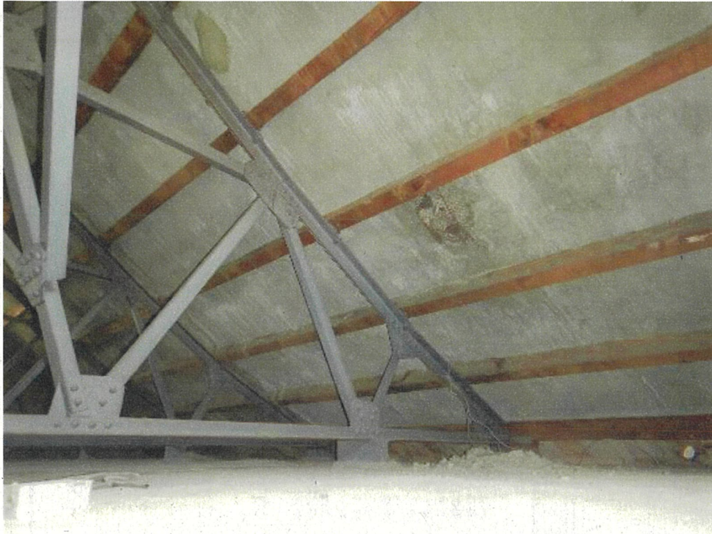
写真 27 西教寺本堂 小屋組鉄骨トラスおよび屋根裏
