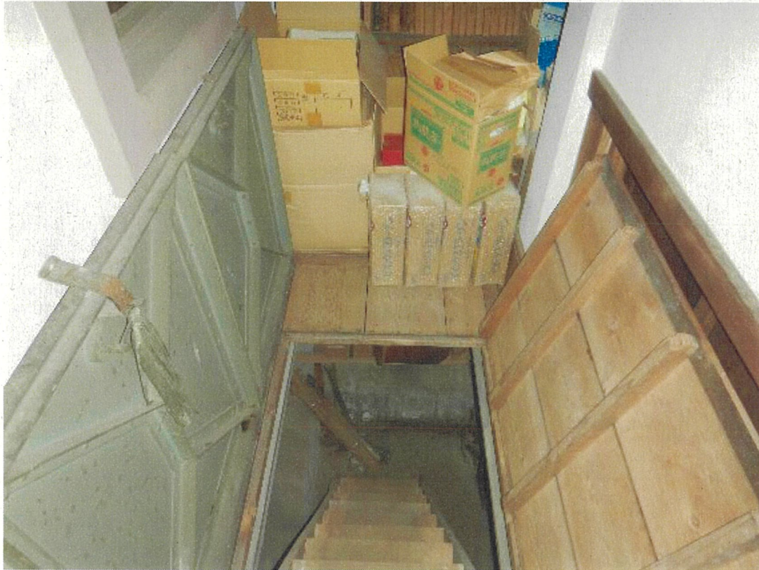
写真 23 西教寺本堂 背面廊下東端部の地下室昇降口 鉄扉を備える
