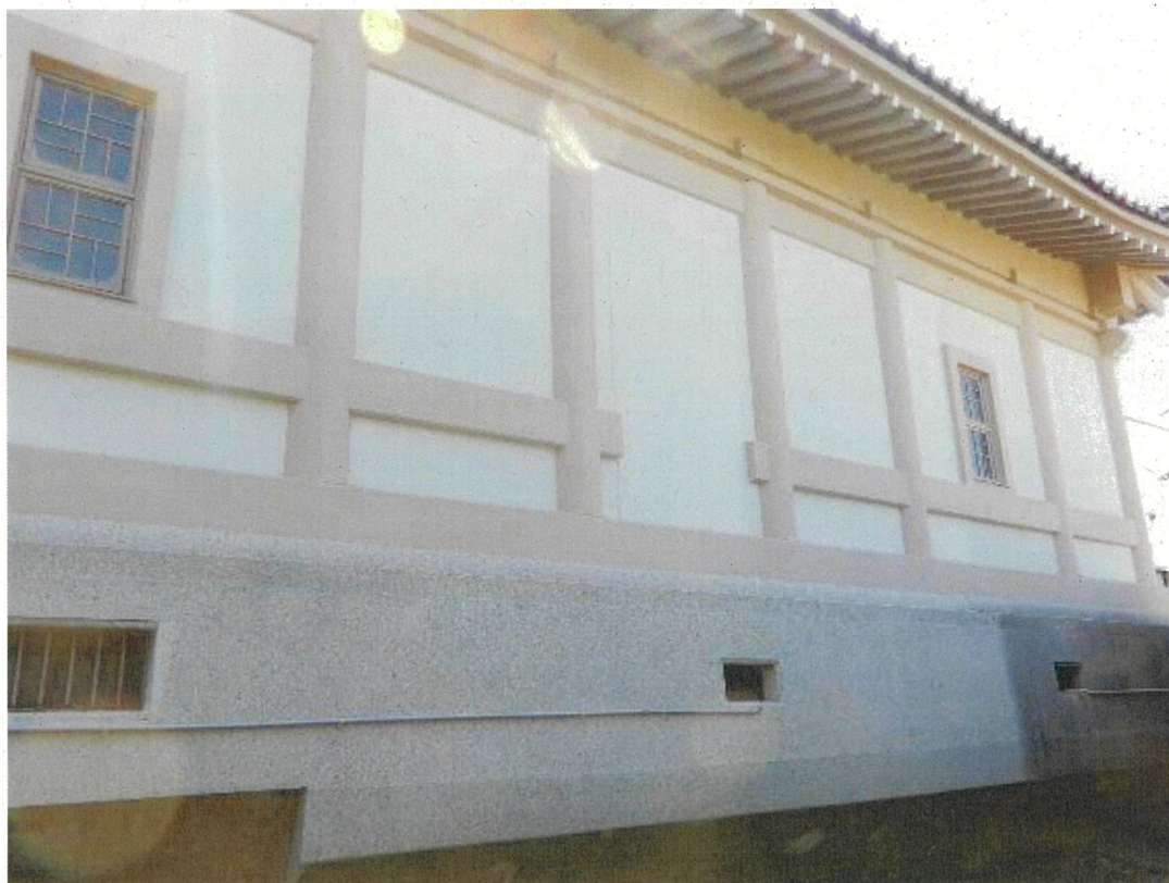
写真5 西教寺本堂 背面（北面） 中央間は本来窓であったが平成8年(1996)に背面に物置を設置した際に窓を出入口に改造した。しかし物置は令和2年(2020)に撤去して出入口は仮設的に塞いでいる。
