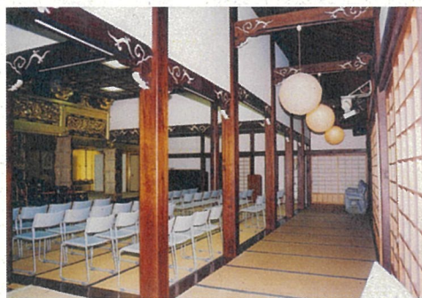
参考図2 浄土寺本堂 (横須賀市逸見) 正徳二年(1712) M28 由緒書、 元茅葺、内陣と外陣内側丸柱、 側廻り三斗組、内陣と余間上段、 S58 R C 基壇上に曳家して修理
