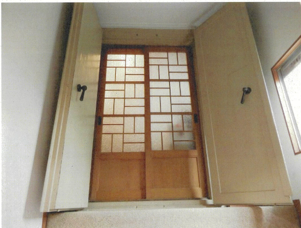
写真 22 西教寺本堂 西側面の開口（後方の廊下部分の連絡口） 本堂西側面には前端間と上記写真の 2 か所に庫裏への連絡口を設けている。前端間の間口幅の方が広いが、内側に木製腰高ガラス障子、外側に鉄製扉両開を設ける点は共通している。
