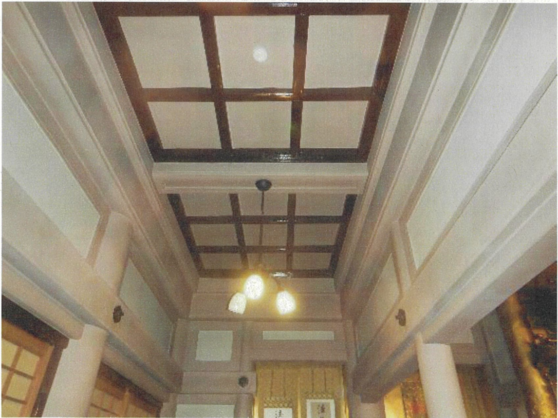
写真 20 西教寺本堂 西余間 天井見上げ
