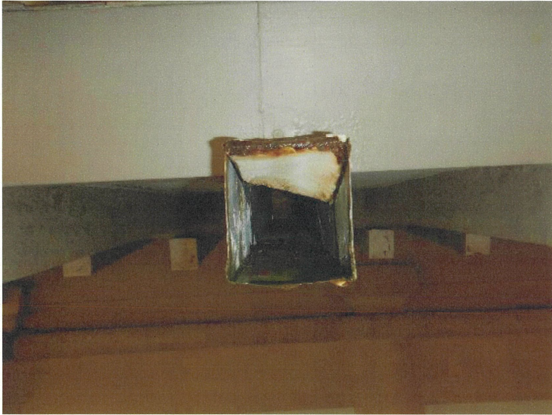
写真 11 垂木木口詳細 木口が奥に入り込んだ状況によって、垂木が板金成形であることがわかる。
