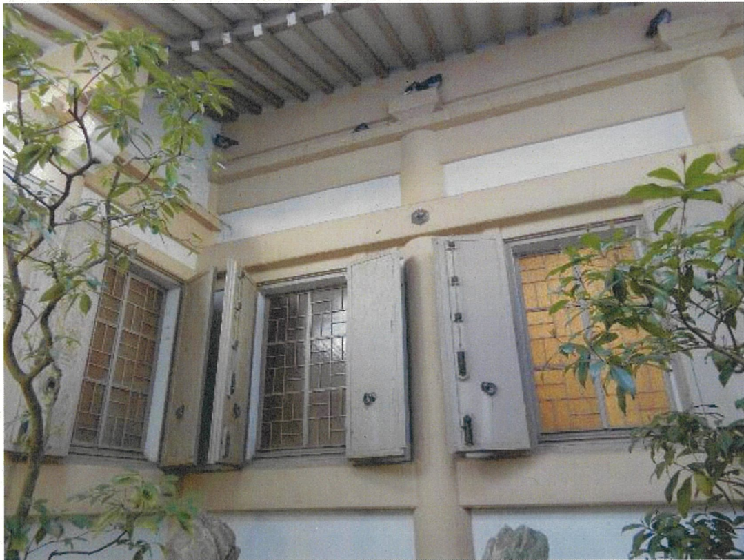
写真 21 西教寺本堂 西側面 鉄製ガラス窓の外側に鉄製扉を備える。これはこの部分が木造庫裏に臨んでいたためらしい（庫裏は昭和 55 年・56 年に RC 造に建替した）。
