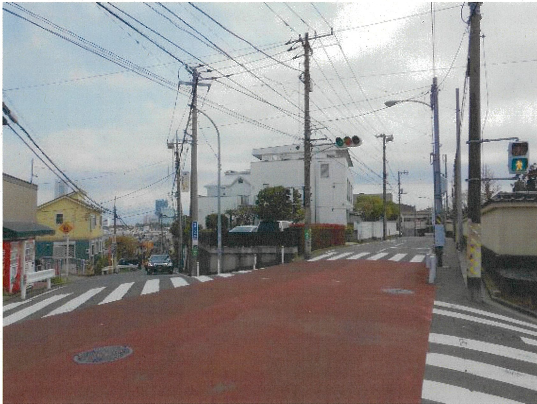
写真1 「久保山霊堂前」バス停前の4差路から東方の西教寺寺地を見る 中央の三角形の敷地が西教寺の寺地で、白い建物は庫裏。南面道路（写真の右中から左下へ延びる）が尾根道で、尾根道の南側と北側は下り斜面となる。
