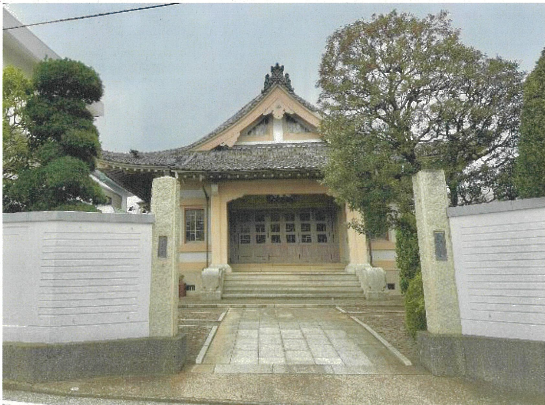
写真2 西教寺本堂正面全景 入母屋造・妻入・棧瓦葺の1重仏堂で正面に向拝を構える。
