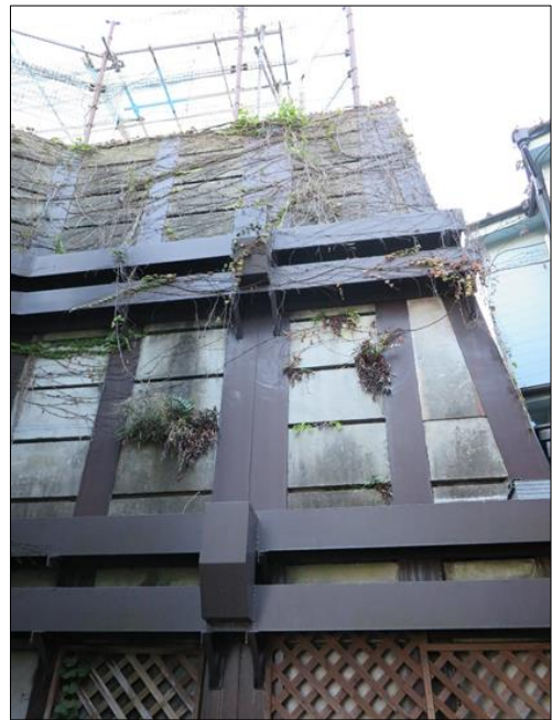
【写真】補強擁壁（★部分）
