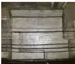
▲開削トンネル構築補修
