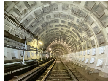
▲シールドトンネル構築補修
