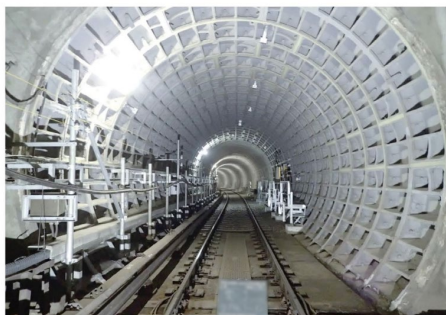
シールドトンネル補修
