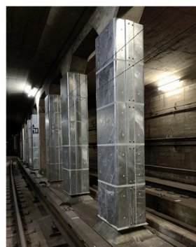
トンネル部の耐震補強工事
