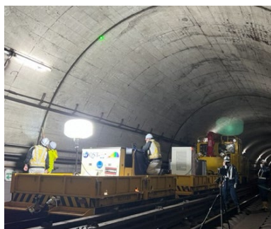
レーザーによるトンネル壁面の打音検査
