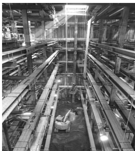
《工事現場の様子》
