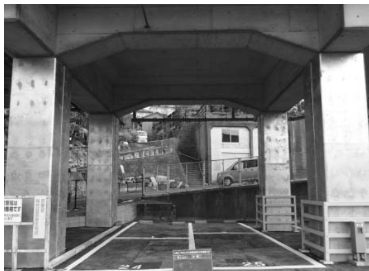
《ラーメン高架橋の橋脚の補強》
