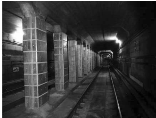
《開削トンネル中柱の補強》
