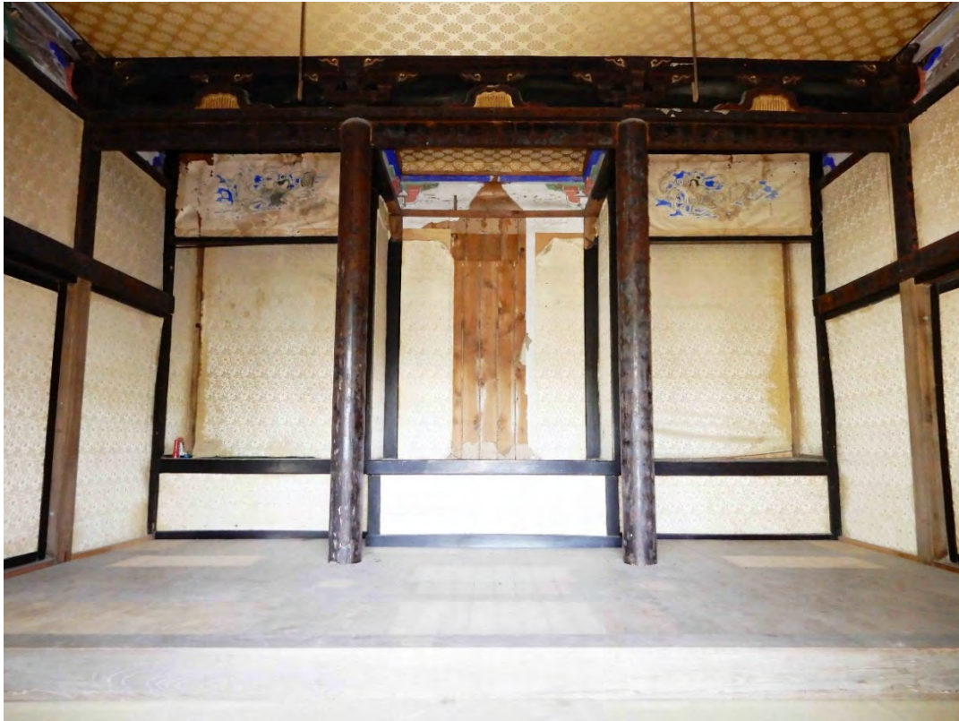
13 如来堂内部 正面中央扉口から内陣(上段)を望む 内部は後方2間分を上段とする(床板は張替)。上段構えは框の取付状態や側面建具のおさまりから見て当初である。一方、上段の中央に丸柱による柱列を設け、丸柱から背面柱へ頭貫と台輪で区画する。天井・壁・建具は唐紙貼付仕上げであるが、現状の天井唐紙は屋根銅板葺きの際に施工したものであろう。柱・長押・組物等は、素木、白檀塗、塗装彩色の3種類の扱いが併存する。
