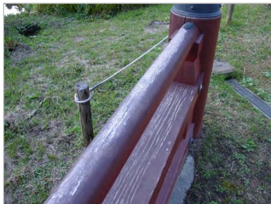
③反橋 特に退色・摩耗が激しい部分
