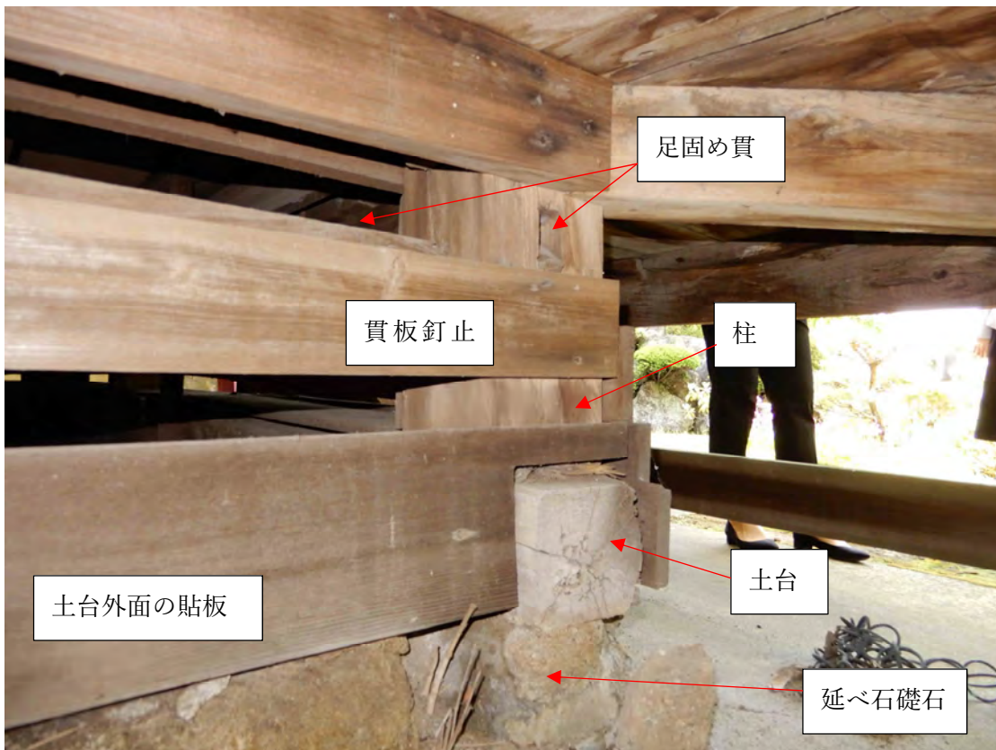
10 如来堂 柱足元 (東側面前端部) 建物は鎌倉石の基礎(延べ石)上に土台を据え柱を立て、柱足元を足固め貫で繋ぎ、柱外に貫板を釘止する。土台建形式は震災後の修理か否かは不明であるが、江戸時代の仏堂建築は柱が独立して礎石上に立つのが通例なので、改修されている可能性は高い。柱足元は比較的健全と思われる。
