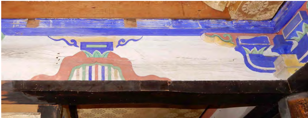
28 如来堂内部 内々陣側面の描画墓股詳細 墓股の描画は良く描けているが、おさまりから見て明治45年銘の厨子(宮殿)を納める際に施工したと考えるのが妥当である。
