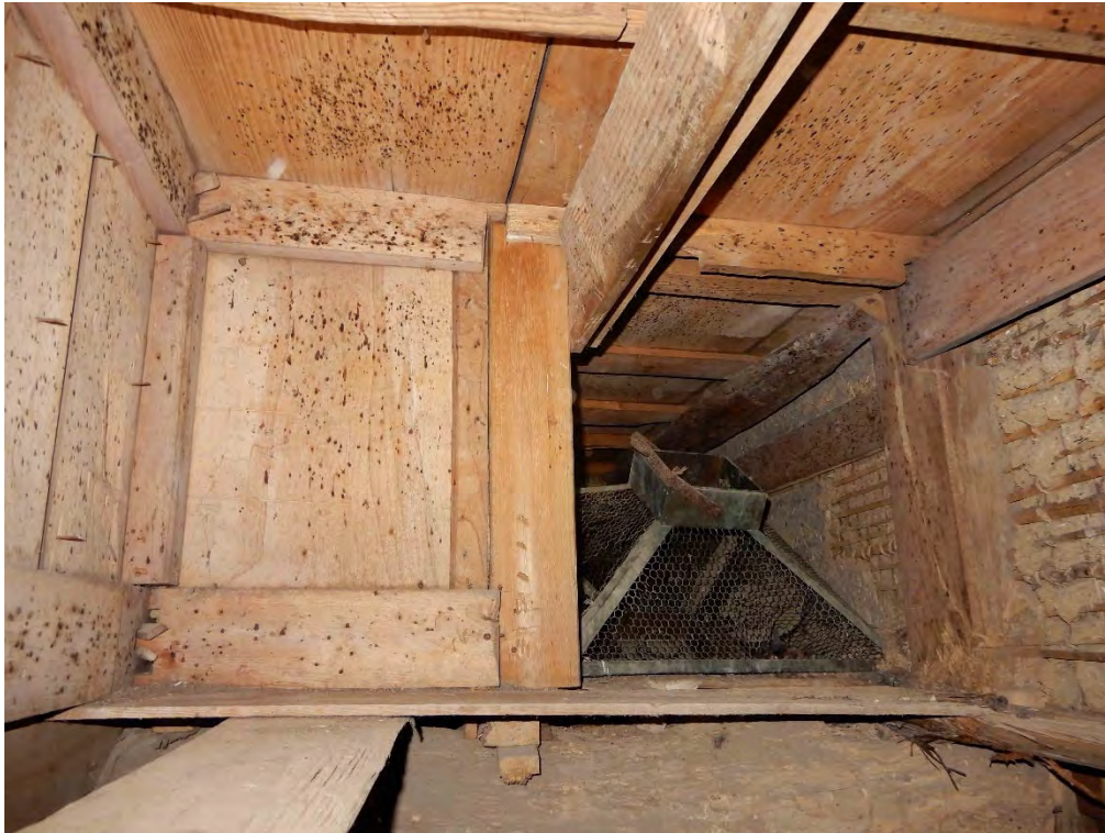
3 2 如来堂床下 (須弥壇と脇仏龕ないふ) 中央の束柱は須弥壇上端で切断されている。元は仏龕柱であったと思われるが、当初まで遡るか否かは確認できない。風合いは須弥壇材より新しいようにみえる。
