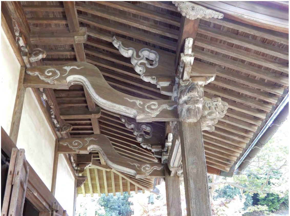
4 如来堂向拝側面見上げ 向拝柱と如来堂本体柱は海老虹梁で繋ぎ、向拝軒に手挟(か)ぎを配する。これらの絵様や彫形も18世紀後期頃の様式を示している。なお、屋根は本来茅葺きであったが、昭和30年頃に銅板葺に改修したという。その際に軒回りもすべて造り替えているらしい。本体軒は出桁造形式の「せがい軒」であるが、本体と向拝の組物部材のおさまりからみて基本的に旧形式を踏襲して新造したと考えられる。
