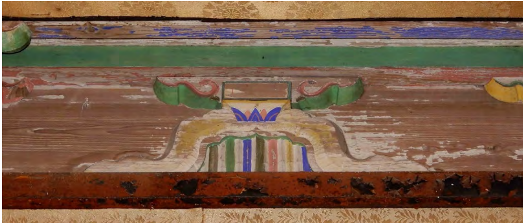
27 如来堂内部 正面の中備墓股詳細 組物と中備は、金箔と透漆で仕上げる部分と、彩色する部分と、素木のまま絵様のみ黒塗りするものの3種類が存在する。素木の状態が当初形式と思われる(写真21,22参照)。
