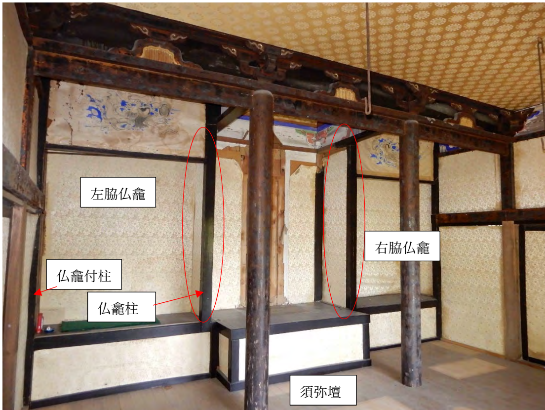
17 如来堂内部 丸柱列奥(内陣)の須弥壇と脇仏龕 丸柱列奥の方1間部分は丸柱と背面柱を頭貫と台輪で繋ぎ(現在頭貫は切除)を内々陣的に区画する。そして箱型須弥壇を設け、その上に明治45年銘のある厨子(宮殿)を配し阿弥陀如来立像を祀る(現在宮殿修理中で本尊は本堂に仮安置)。左脇仏龕内は厨子入の聖徳太子像(県文化財)を祀る(現在本堂に仮安置)。右脇仏龕内に安置していた像は不明という。写真の楕円内の脇仏龕柱はおさまりが姑息である。
