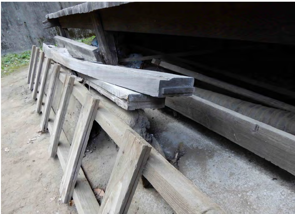
12 如来堂背面軒下に保管されている旧如来堂敷居と思われる部材 こうした部材は本来の形式を伝える重要な無事なのでしっかりと記録を採ったうえで保管する必要がある。
