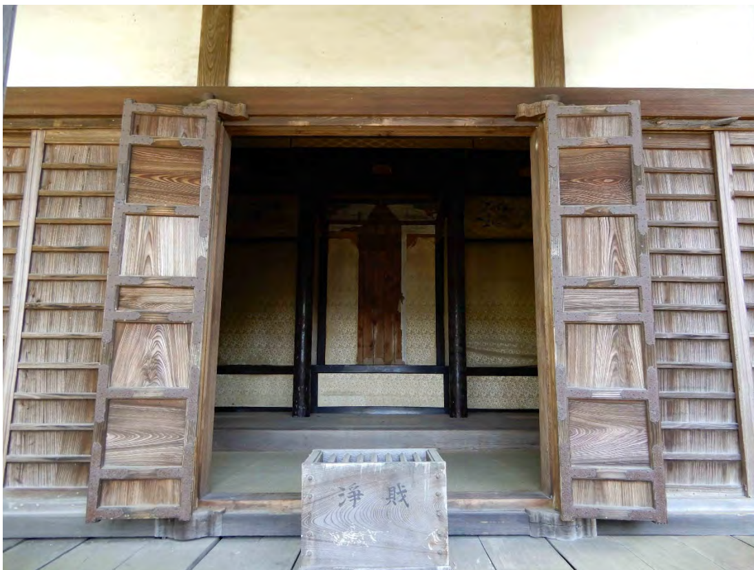
6 如来堂正面の建具 中央間はもろ折れ棧唐戸を藁座にて吊り込む。両脇間は舞良戸引き違いとする。建具は何れも本来の形式を良くとどめていると思われる。
