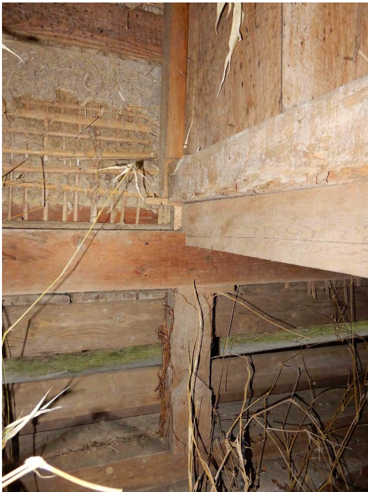
3 2 如来堂床下 (須弥壇と脇仏龕ないふ) 中央の束柱は須弥壇上端で切断されている。元は仏龕柱であったと思われるが、当初まで遡るか否かは確認できない。風合いは須弥壇材より新しいようにみえる。
