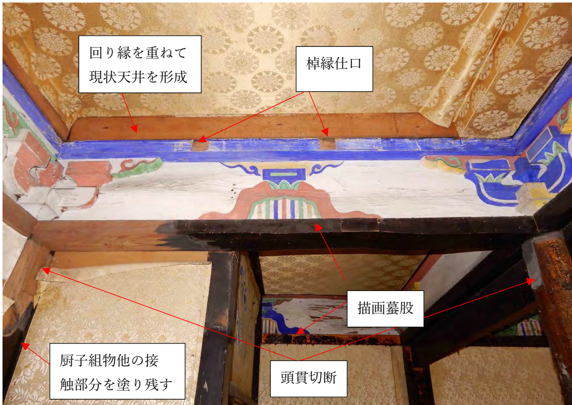
21 如来堂内部 丸柱列奥(内陣)中央西側面上部 頭貫切断他改造状況 内陣西側面にも半分描画墓股が存在する。天井クロス張の仕事が粗い(脇間天井は黒塗の四分一取付)のは、小屋裏から施工したためらしい。
