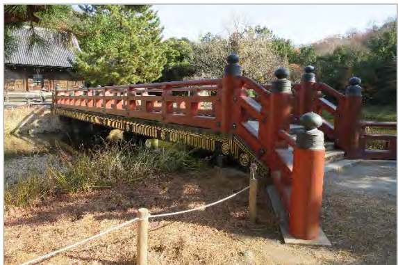
③反橋 特に退色・摩耗が激しい部分
