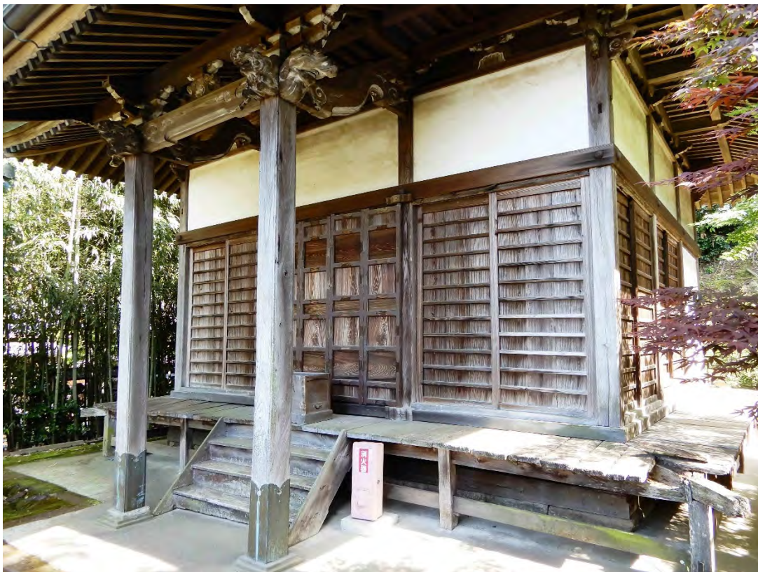
2 如来堂正側面 (北西から見る) 如来堂は境内南西方の谷戸奥のやや高い場所に北面して建つ。桁行3間・梁行3間(ともに18.6尺)、宝形造・銅板葺屋根で、正面中央1間に向拝を設ける。
