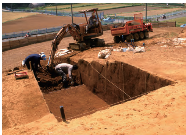
111. 上段下層 A トレンチ 掘削作業
