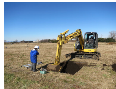
試掘調査の様子
