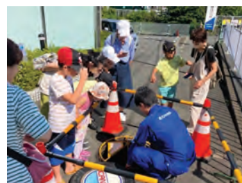
実際にマンホールの中を覗いて説明を聞いている様子
