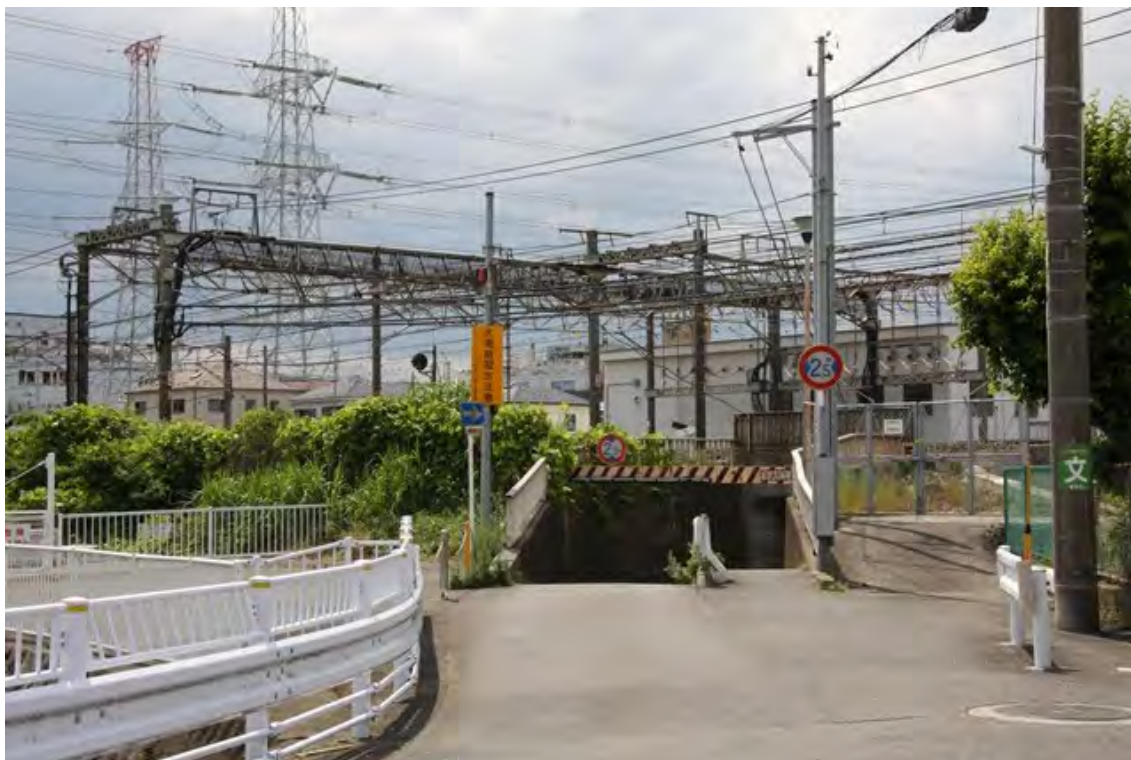
国道 1 号線側から
