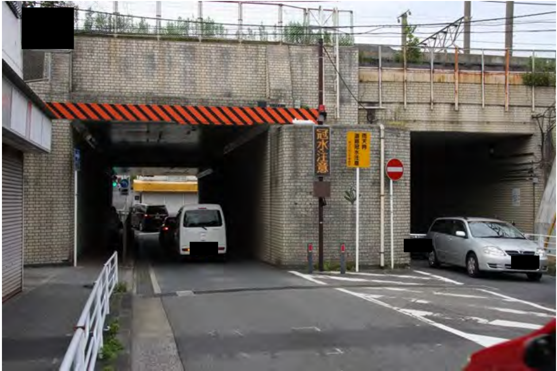
国道 1 号線側から
