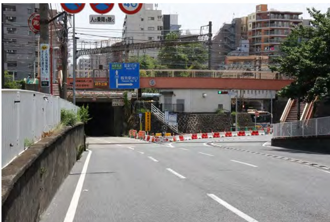
港北区方面側から
