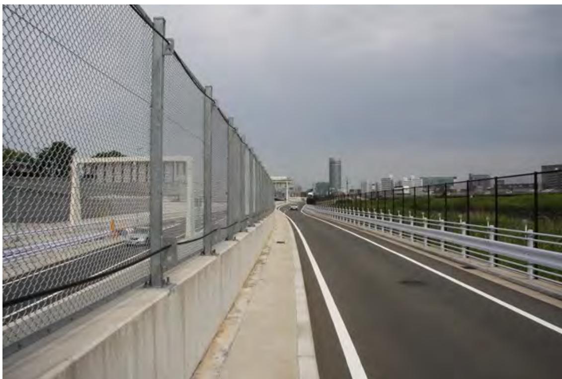
鶴見川上流側から
