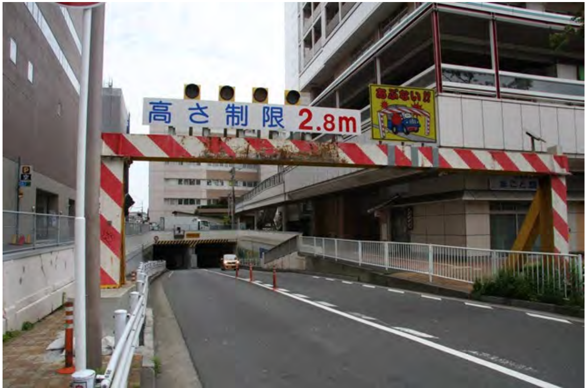
京急線側から
