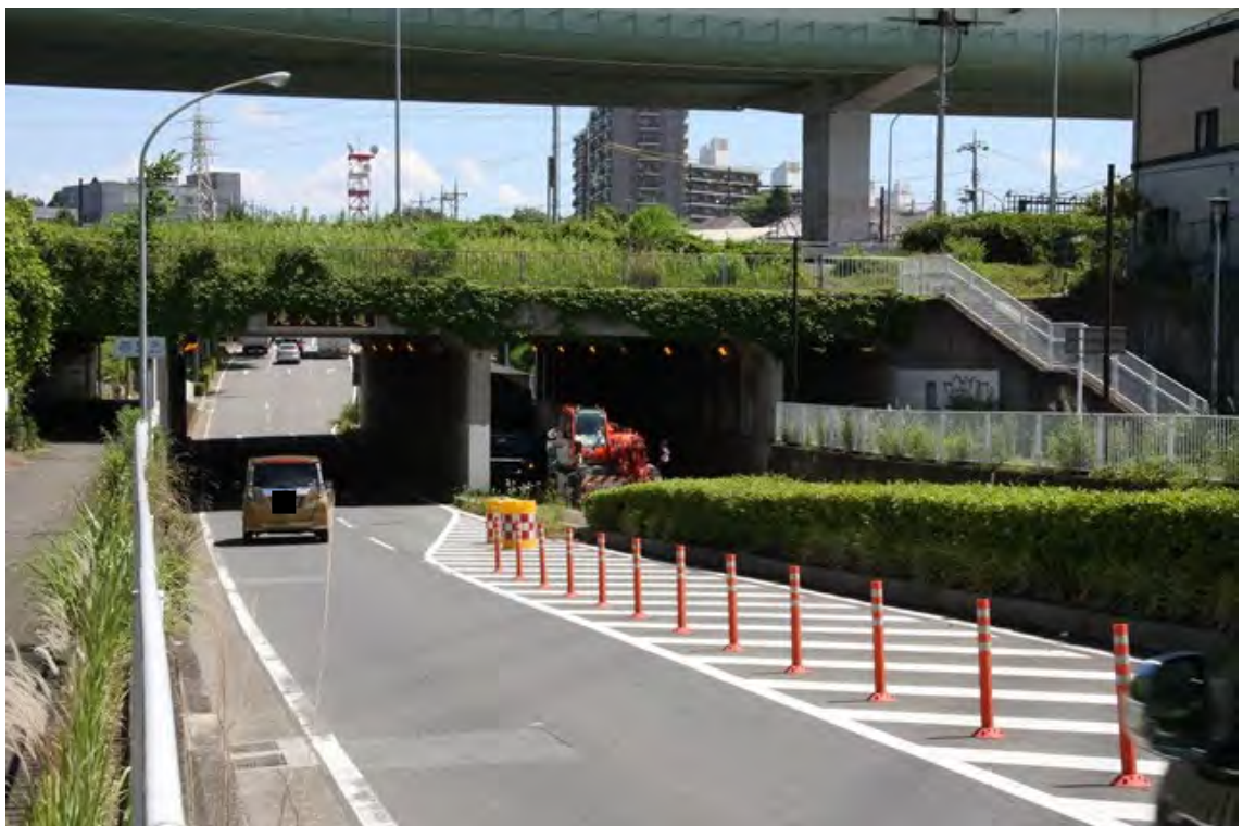
瀬谷区方面側から
