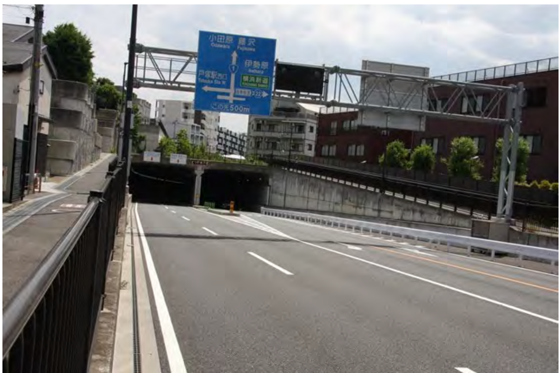
港南区方面側から
