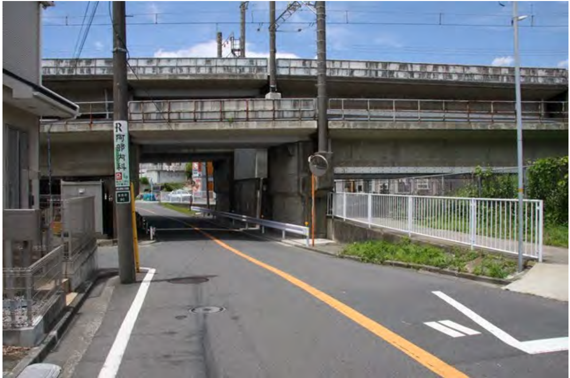
根岸線南側から
