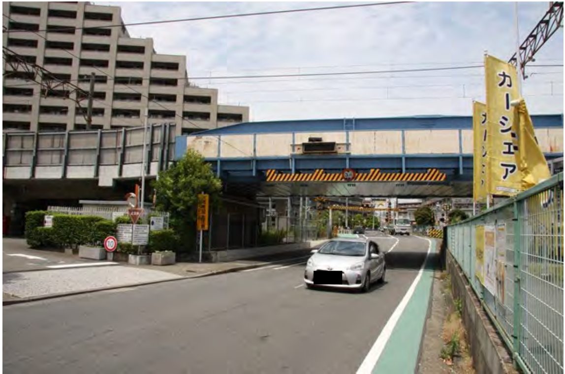
国道 15 号線側から
