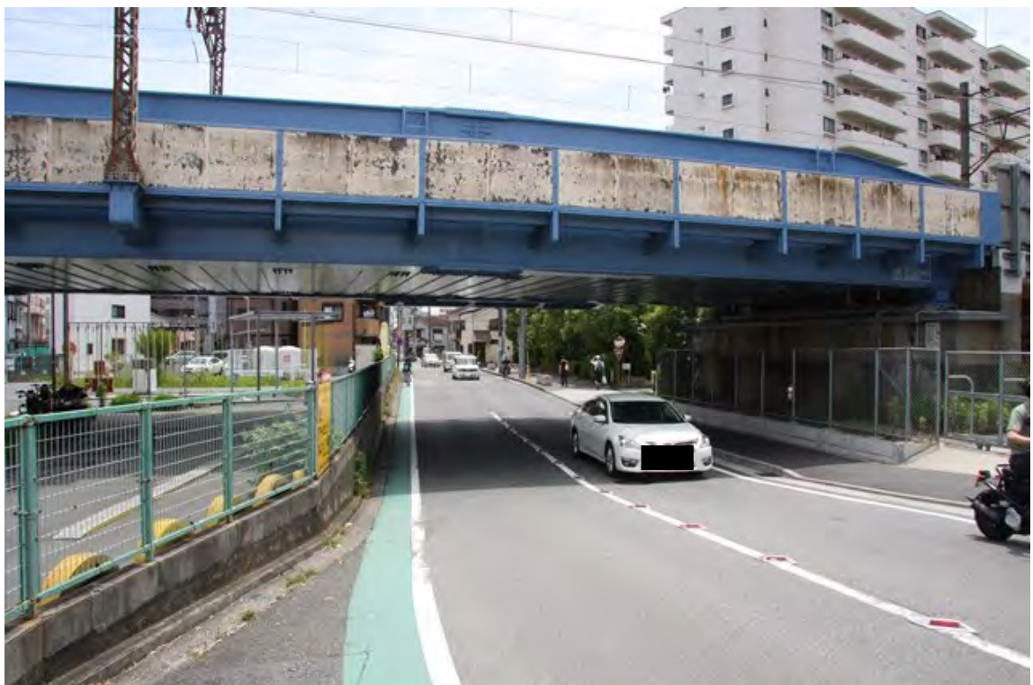
国道 1 号線側から
