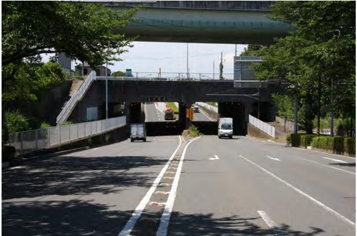
緑区方面側から
