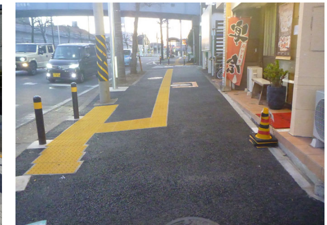
視覚障害者誘導ブロックの設置
