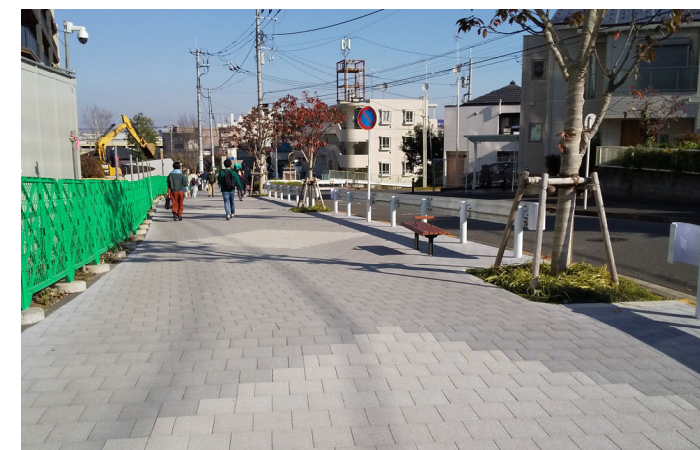
歩道舗装の改修
