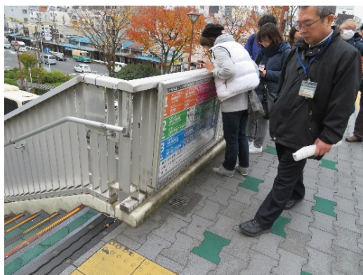
歩道橋の点検
