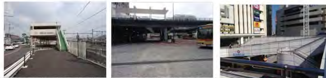
第2バスセンター 第1交通広場 デッキとラピス1のスロープ
