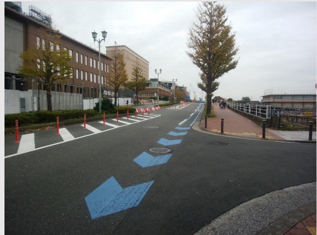
矢羽根型路面標示（万国橋通り 中区）
