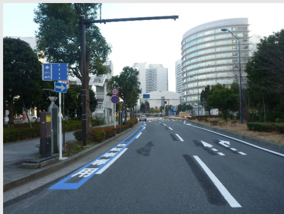
整備された自転車専用通行帯（国際大通り 西区）
