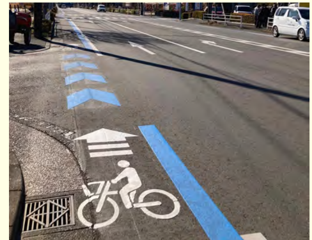
R6整備箇所
