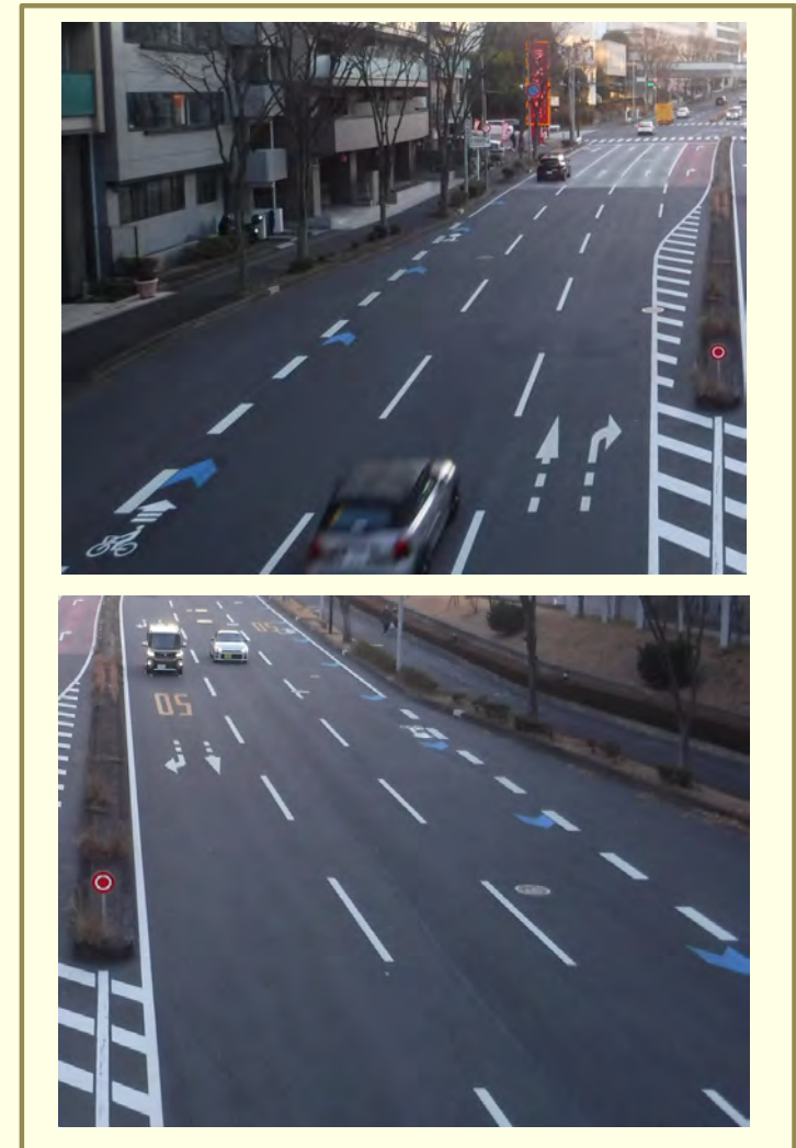
R6整備箇所
