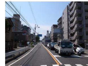
国道1号保土ヶ谷橋工区
