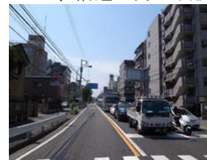
国道1号保土ヶ谷橋工区
