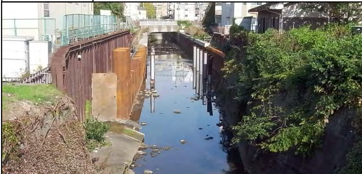
既設下流側支柱状況
