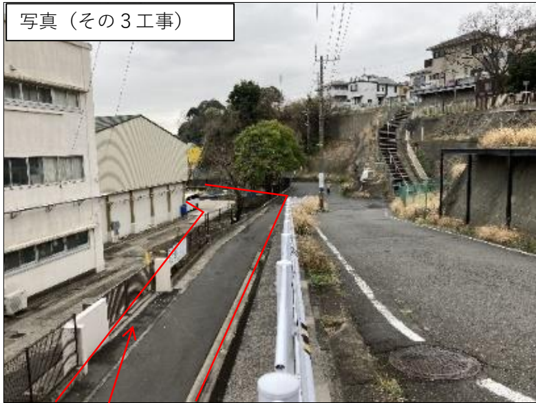
鋼矢板擁壁・付替道路工事
