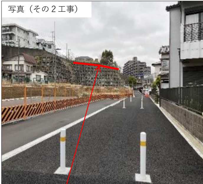
既設擁壁撤去・切土補強土擁壁工事
