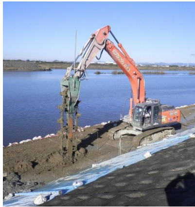
地盤改良作業状況
