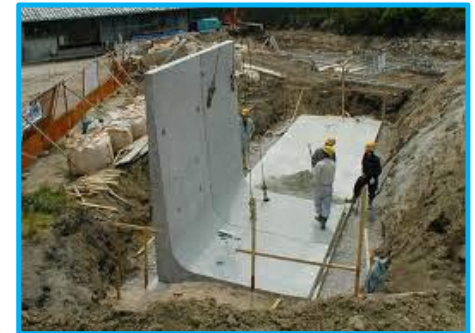
L型擁壁設置作業
