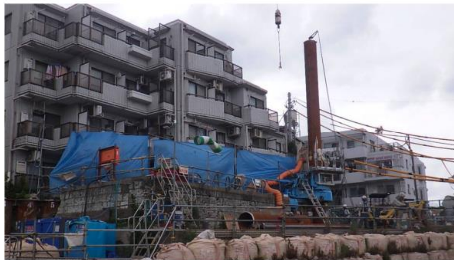
▲施工状況(全体)
