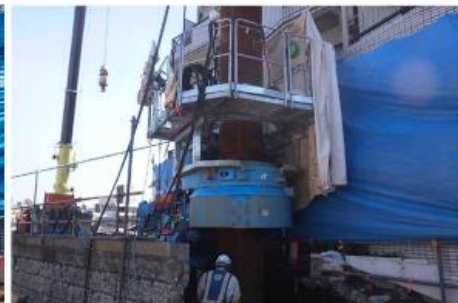
▲近接施工状況
