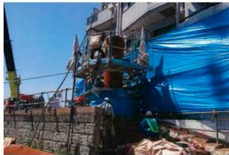
▲近接施工状況
