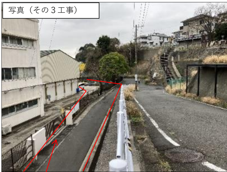
鋼矢板擁壁・付替道路工事
