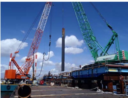
鋼管矢板切断・撤去
