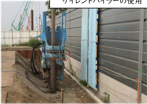
サイレントパイラーの使用
