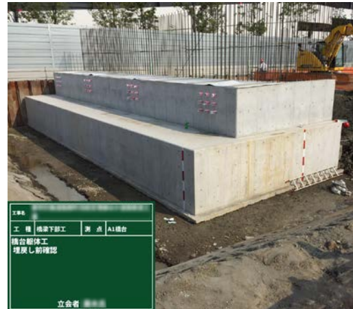
コンクリート基礎構築
