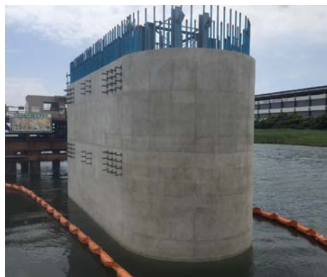
橋脚構築完了
