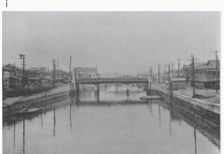
復興事業で架け替えられた武蔵橋（昭和3年1月29日竣工）
