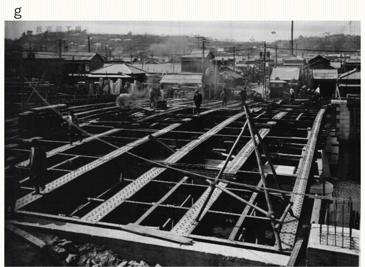
阪東橋の新設工事状況（大正15年10月竣工）
