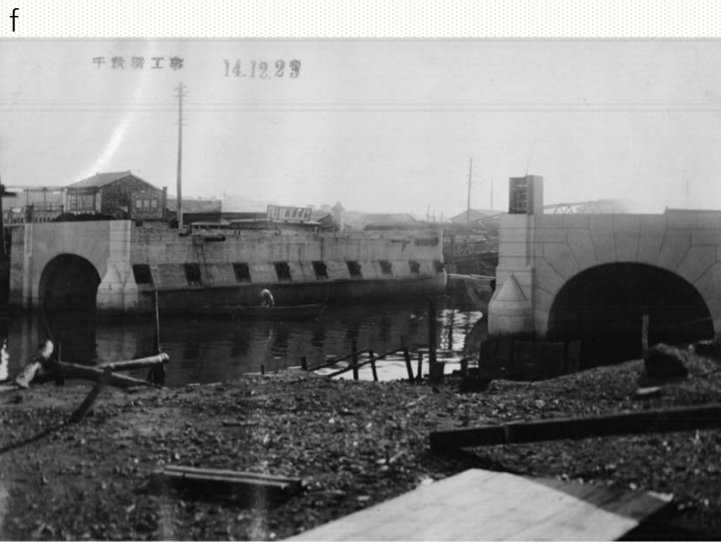
千秋橋の橋台築造後、この後に桁が架けられた (大正15年4月竣工)
