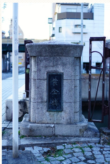
右岸下流側より親柱を望む
