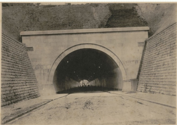
竣工当時の山手隧道(麦田町側)
