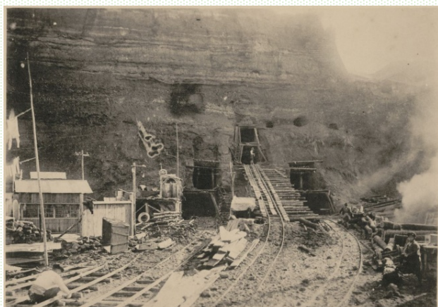
工事着工当時の様子
