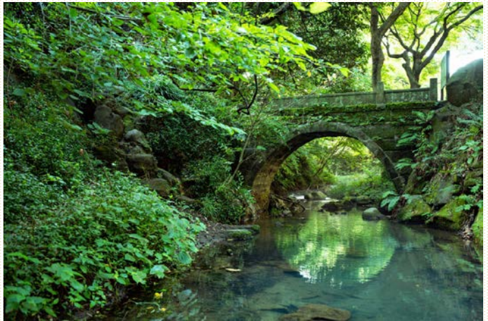
河川形状に沿ったアーチ構造となっており、いたち川源流部の景観との親和性が高い。
