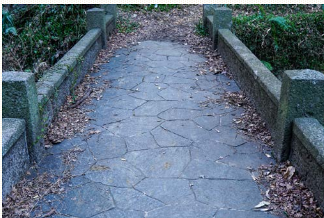
路面は平成2年の補修工事にて、現在の模様となっている。全体のバランスを崩さないように平石での化粧となっている。
