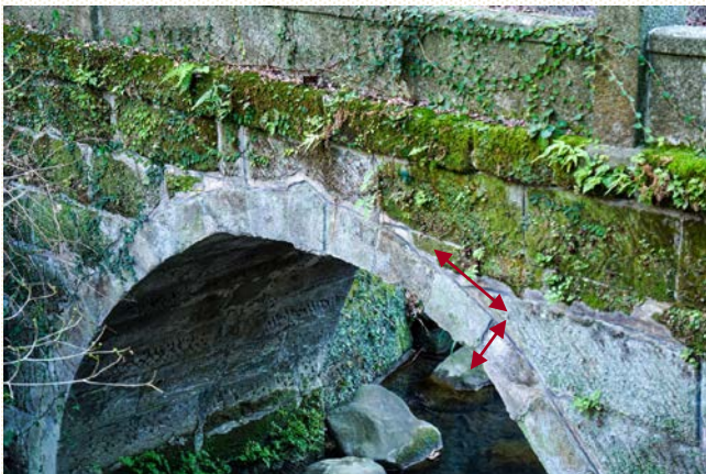
輪石の幅と厚さの比がおおよそ3:2となっており、九州・沖縄地区のものとは比べ薄い構造で、緻密なデザインとなっている。
