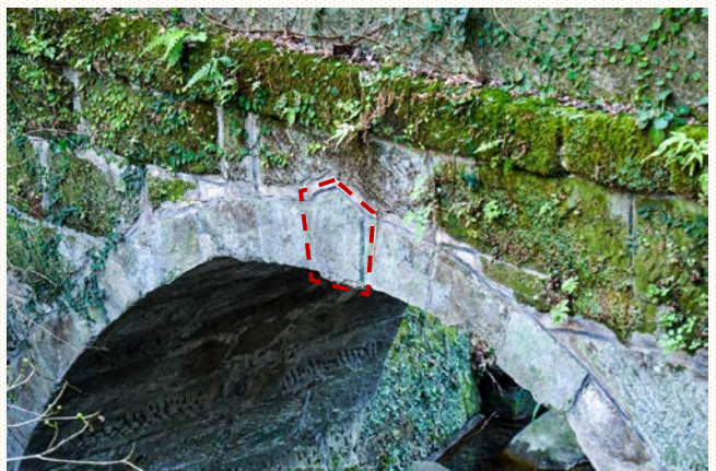
要石が五角形をしており、石橋では非常に珍しい。また要石上部は三角に掘られ、要石と一体となるような意匠で、施工の緻密さが伺える。
