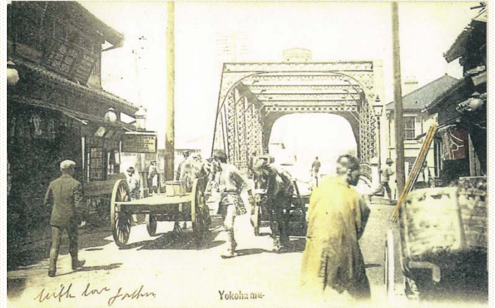
プラットトラスの西の橋
