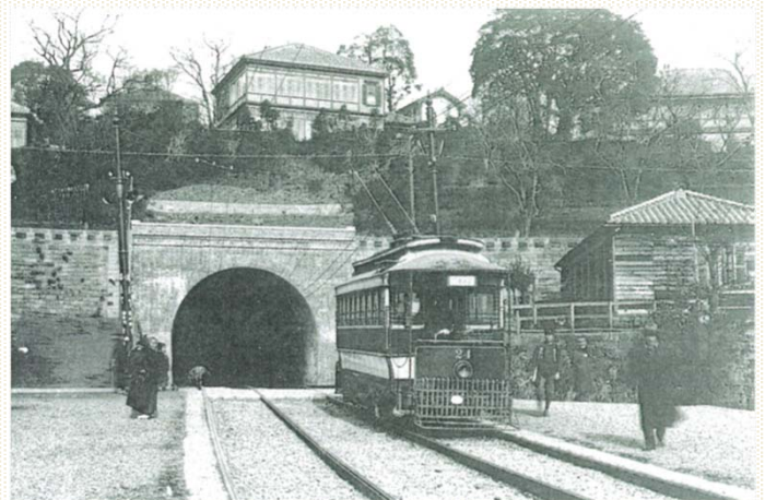
西の橋の先には桜道トンネル（現：第二山手隧道）がある写真は本牧方面からトンネルを望む
