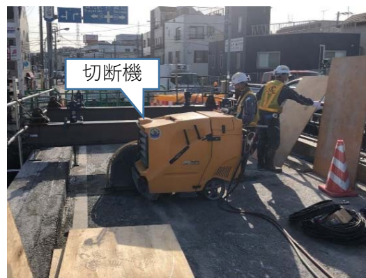
大きな刃が付いている切断機で床版を切断している状況
